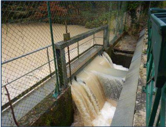
Figure 78 : Photographie du système de vannage régulant le niveau d'eau du Grand canal
