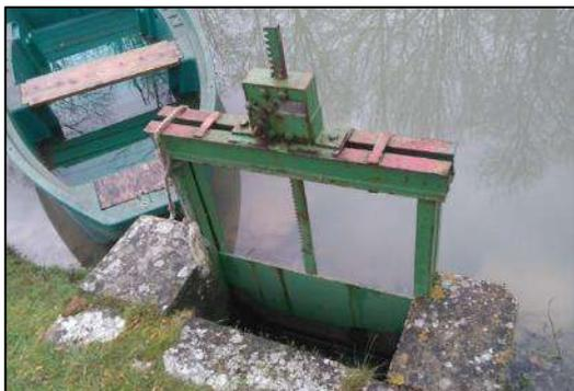
Figure 11. Système d'alimentation des douves
